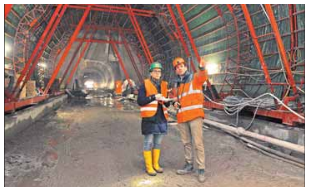
Bauleiter Ralph Eckerle (rechts) erklärt RNZ-Redaktionsmitglied Laura Geyer ganz genau, was im Branichtunnel gerade vor sich geht.
