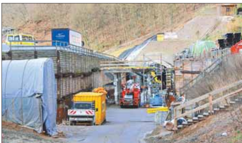
Im offenen Bereich des Ostportals liegen schon die Bodenplatten, und die ersten Wände sind betoniert. Wenn die Wände stehen, wird das Dach aufgesetzt, wie bei einem Haus.
